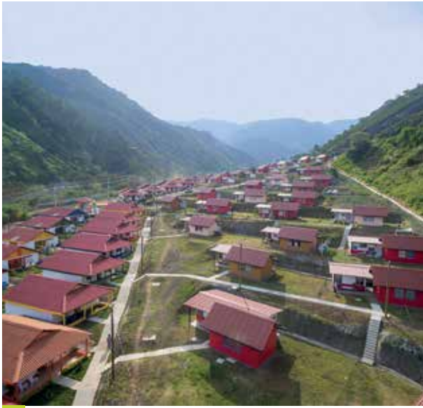
Proyecto construcción de vivienda rural, Salgar, Antioquia, Colombia
